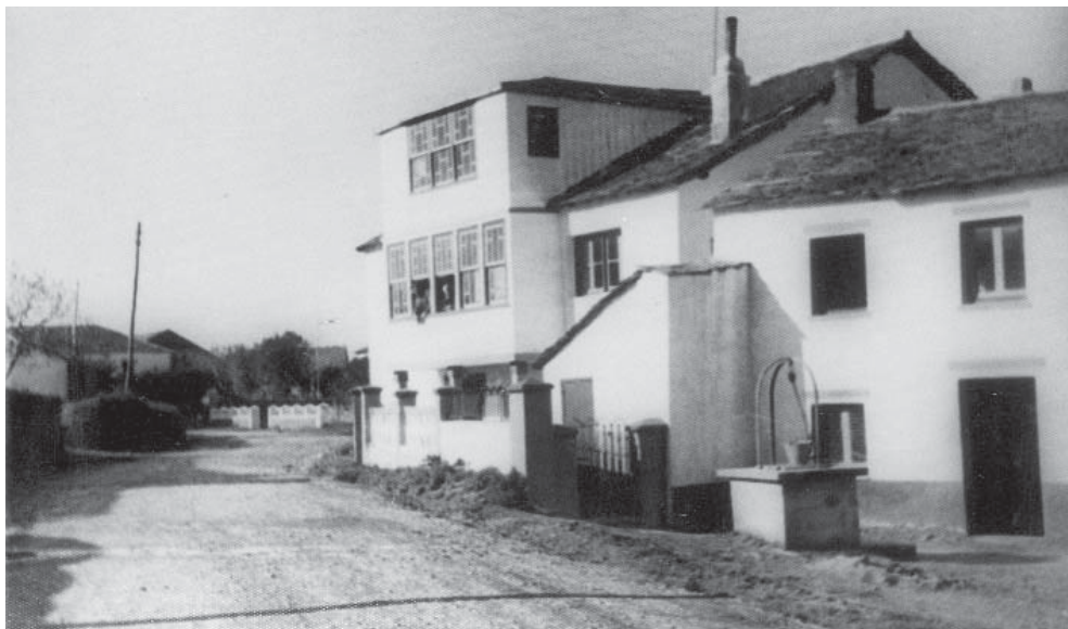
VISTA PARCIAL Con la carretera a Vigo aún sin asfaltar.
